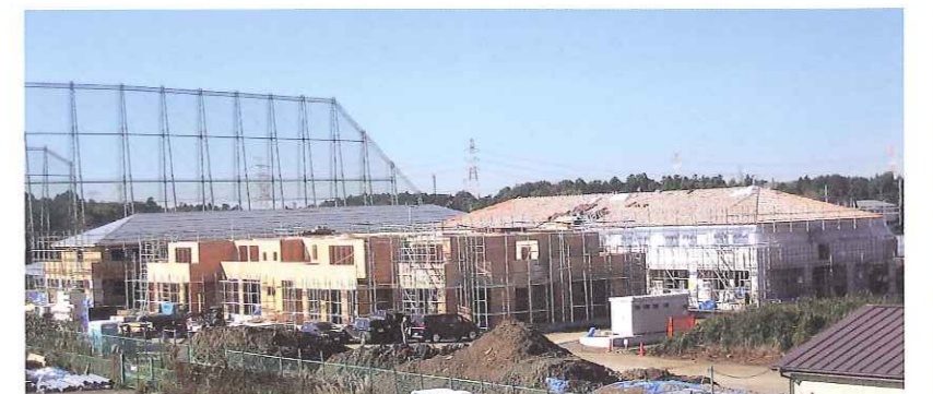
3棟で段階的に工事が進む様子がわかる
