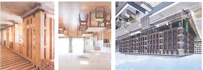
施主: 社会福祉法人 聖風会 設計: 株式会社 ムツア 施工: 三井ホーム株式会社 ●構造: 2x4工法とその他による混構造 (1階: 鉄筋コンクリート造、2階から5階: 2x4工法(耐火構造)の立面混構造) ●敷地面積: 4,561.39㎡、建築面積: 2,495.89㎡、延床面積: 9,773.24㎡ ●階高: 5階建 ●竣工日: 2016年6月
