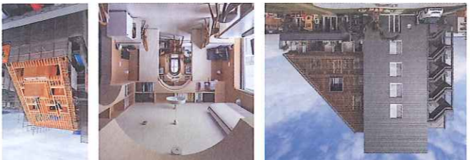
施主: 株式会社 リナ 設計: 株式会社 市川宣建築士事務所 施工: 株式会社 リナ ●構造: 2x4工法とその他による混構造 (1階: RC造、2階~5階: 木造(2x4工法)の耐火構造) ●敷地面積: 511.42㎡、建築面積: 284.57㎡、延床面積: 1,015.02㎡ ●階高: 5階建 ●竣工日: 2016年9月
